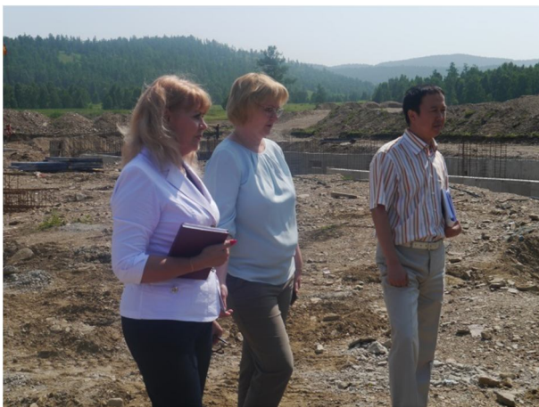
На стройке нового корпуса Туимского интерната
